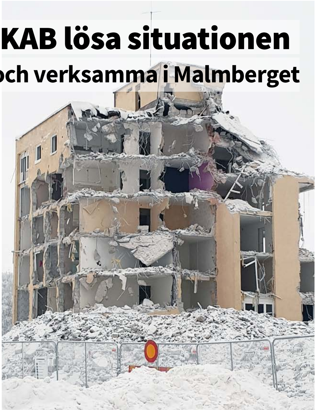
Under pågående rivningar har Malmbergets Centrum kunnat liknas vid ett krigsområde i vilket ett par företag tvingats vara kvar. Detta har förstås inneburit stora konsekvenser för företagets verksamheter.
